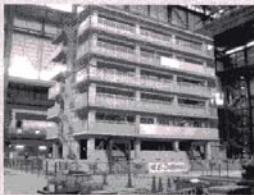
実験棟の面積は約5,200m<sup>2</sup>、高さ約43m。実験大型試験体等を組み立てて解体するための400t高性能クレーンを2台設置している。
