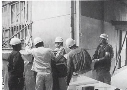
† 下げ振りによる傾斜の測定
