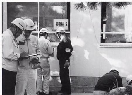
RC柱の損傷度を調査する判定士
